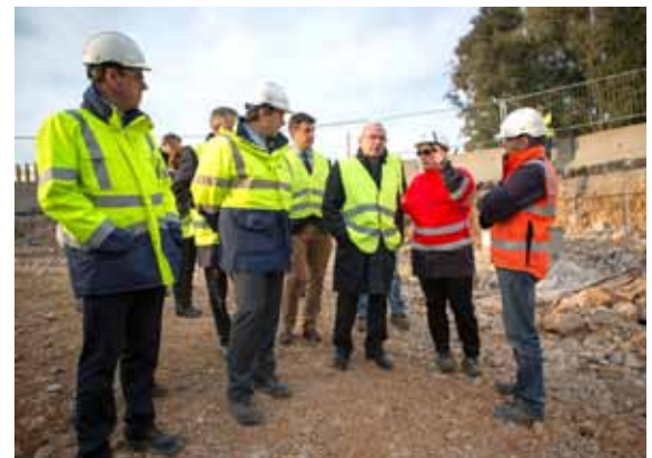
Visite du chantier du bus-tram – décembre 2015
