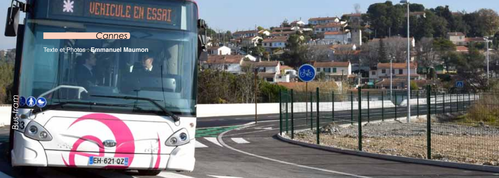
Véhicule en essai sur la voie dédiée aux bus dans le secteur des Trois Moulins
