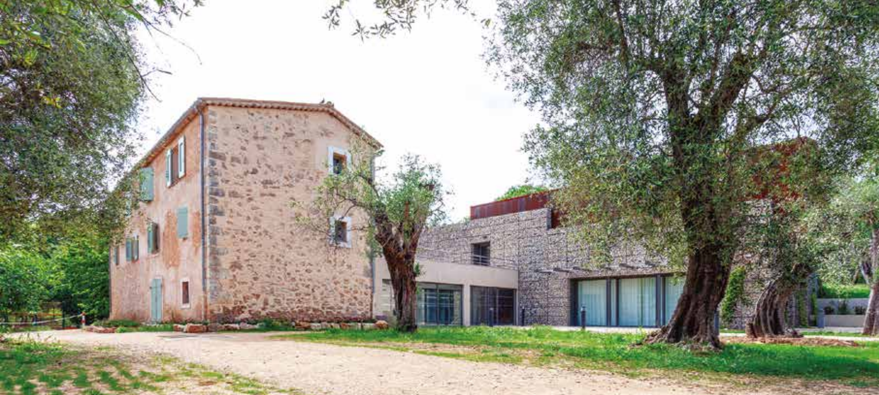
La nouvelle ferme Bermond qui accueille les activités des associations et du service loisirs jeunesse
