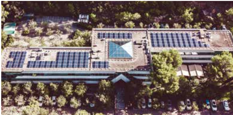
Les panneaux solaires installés sur le toit du bâtiment SAP
