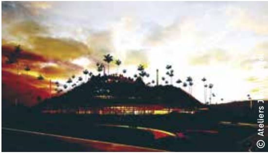
Un bâtiment qui se soulève pour laisser passer la route
