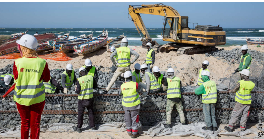
Lutte contre l'érosion côtière par pose de gabions
