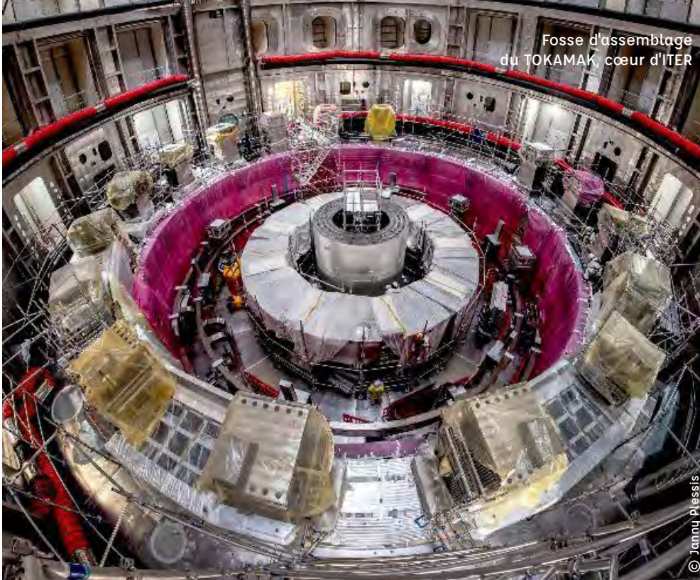
Les plus grosses des bobines annulaires (17 et 24 m de diamètre) sont fabriquées sur site par l'Europe
