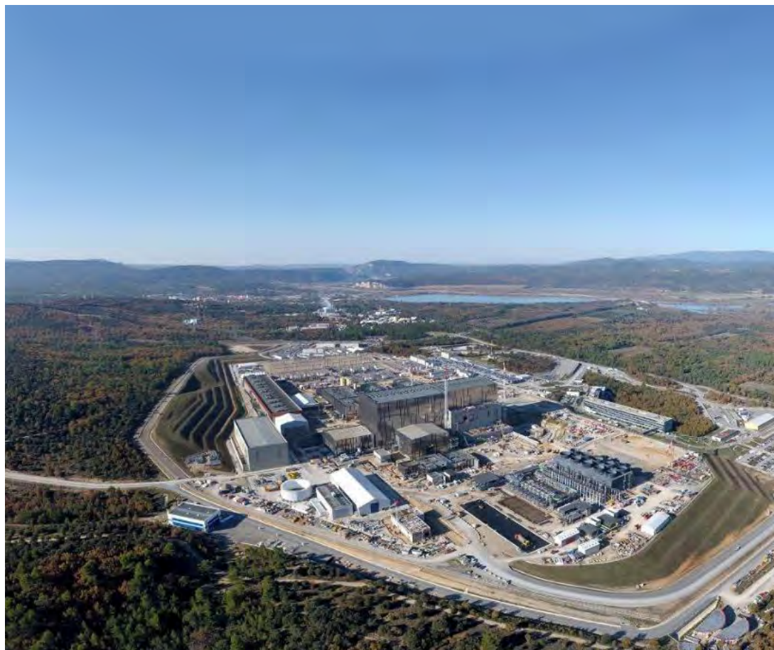
La plateforme de 42 hectares (sur une emprise totale de 180 hectares) où se construit ITER
