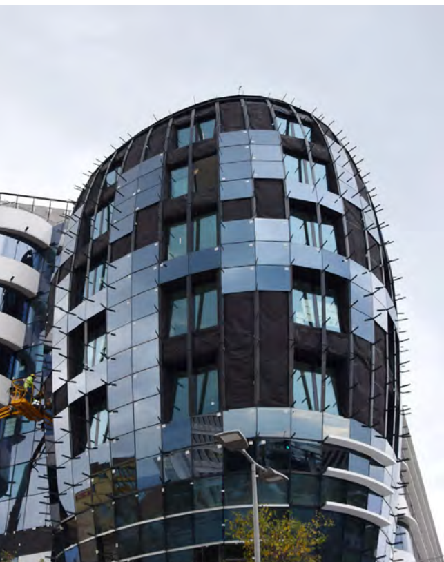
Le dôme du Sheraton en cours de finition
