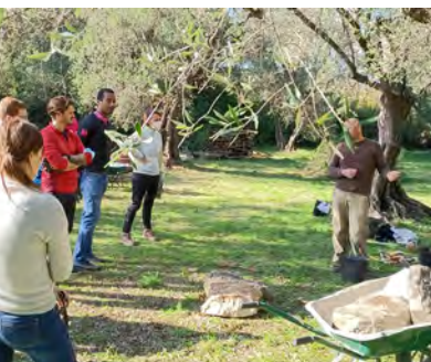
Réfection d'une restanque
