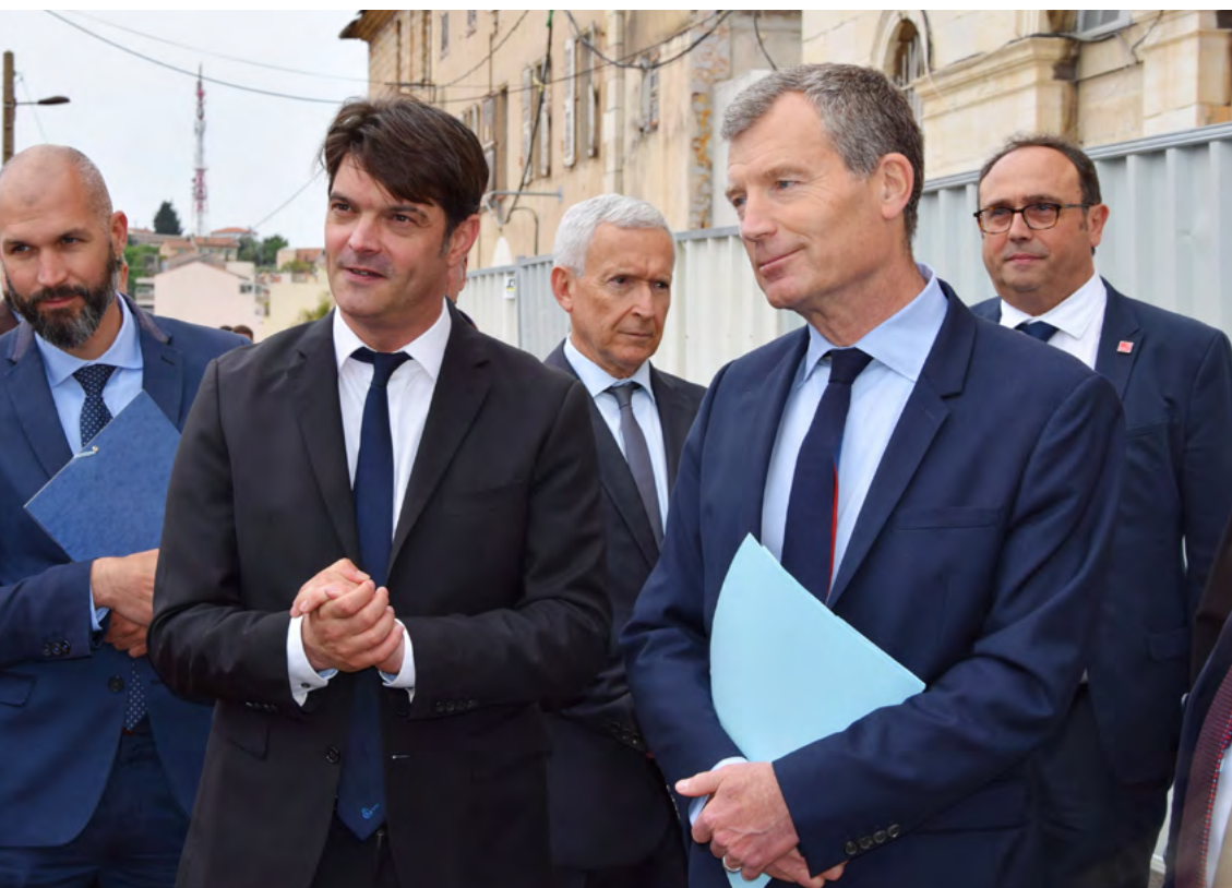
Jérôme Viaud et Christophe Mirmand au cours de la visite du chantier de transformation de l'ancien palais de Justice
