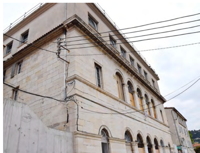
La façade de l'ancien palais de Justice en cours de réhabilitation
